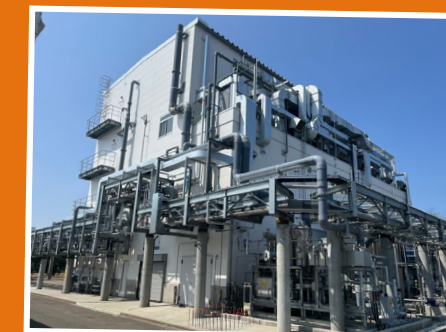
2023年3月電子材料工場を福井工場内に建設
