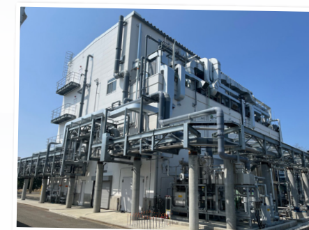
2023年3月電子材料工場建設
