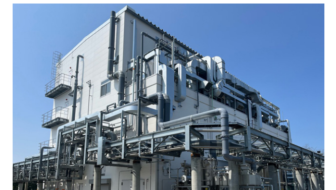
完成時の新工場(2023年3月)
