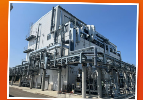
2023年3月電子材料工場建設
