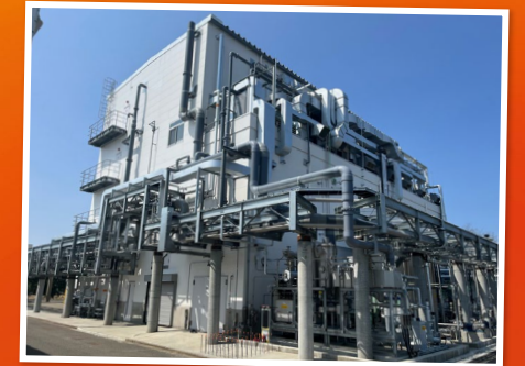
2023年3月電子材料工場建設
