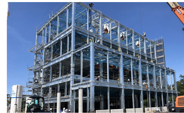
建設時の新工場(2022年7月)
