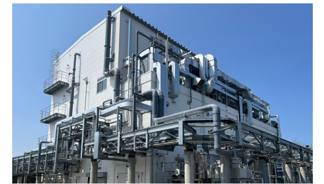
完成時の新工場(2023年3月)
