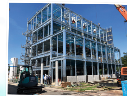
現在建設中の福井第3工場北棟
